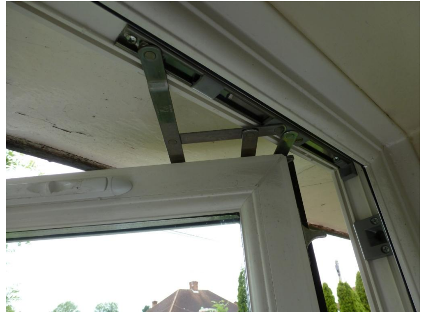
Nůžkové kování umožňující aretaci v libovolné poloze
