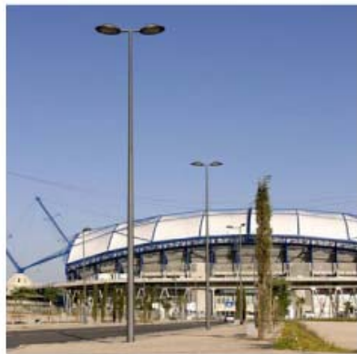
Veřejné osvětlení - svítidlo Schreder Citea Maxi, stožár 12m
