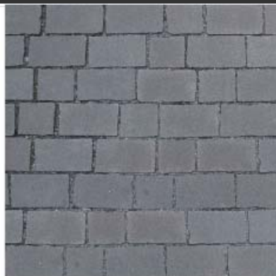
Pojížděný chodník - žulová řezaná dlažba
