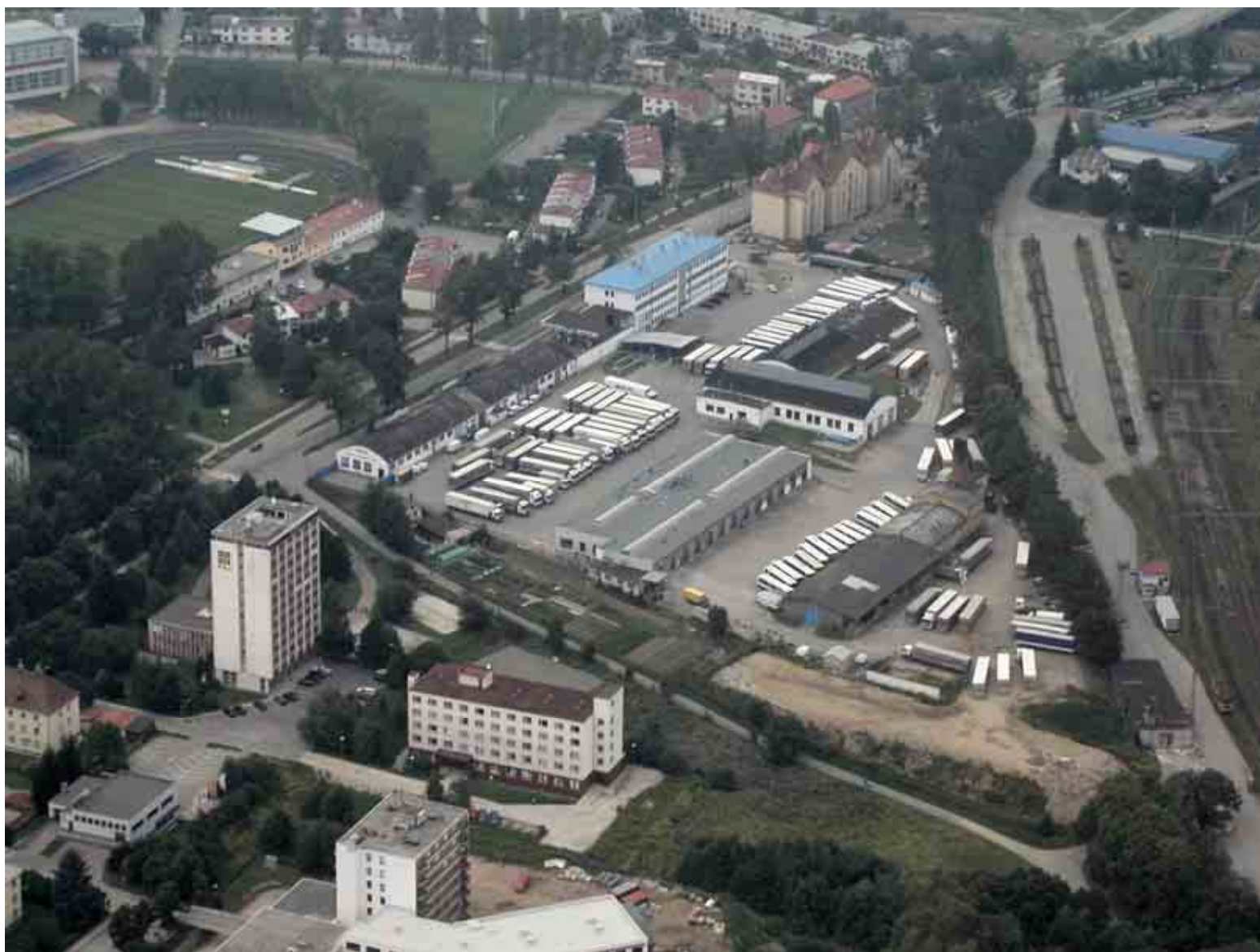
Pohled na areál - stávající stav
