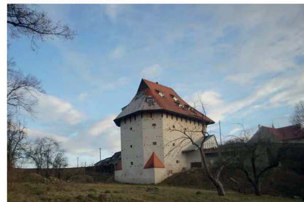
REKONSTRUKCE PRACHÁRNÝ V LEVOČI
