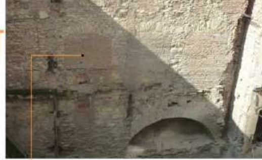
otevření původního otvoru
