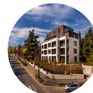
Tepelné čerpadlo s přírodním chladivem R744 Rezidence Červený dvůr
